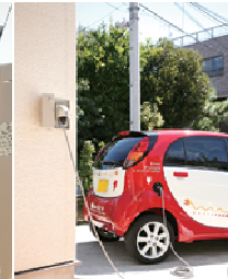
《電気自動車対応 充電コンセント》
