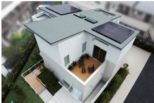
《「レジリエンス住宅CH14」外観》
