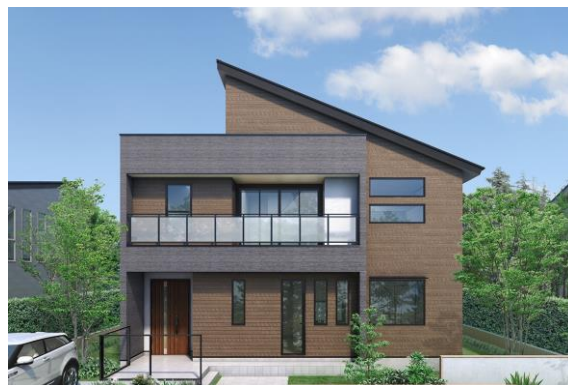
アイフルホーム米沢店 新モデルハウス『セシボ』外観
